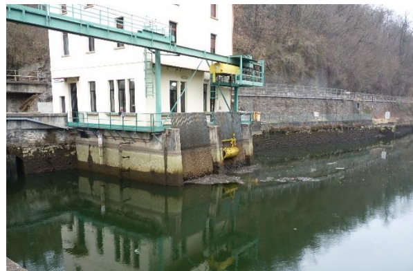
FIGURA 1. LA DIGA E IL PASSAGGIO PER PESCI VISTI DA VALLE (A SINISTRA), L'OPERA DI PRESA (A DESTRA) E LA GRIGLIA DI PROTEZIONE DELL'OPERA DI PRESA (IN BASSO)
