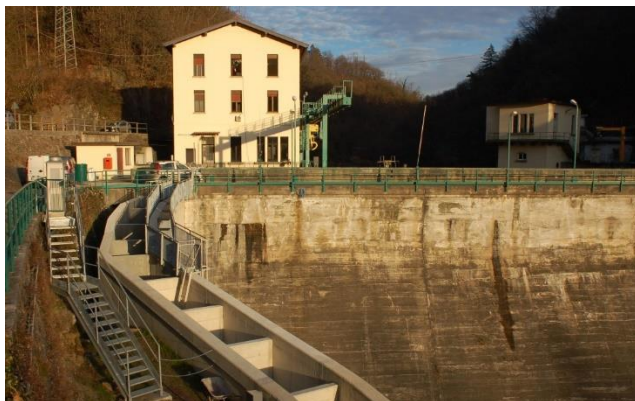
FIGURA 1. LA DIGA E IL PASSAGGIO PER PESCI VISTI DA VALLE (A SINISTRA), L'OPERA DI PRESA (A DESTRA) E LA GRIGLIA DI PROTEZIONE DELL'OPERA DI PRESA (IN BASSO)
