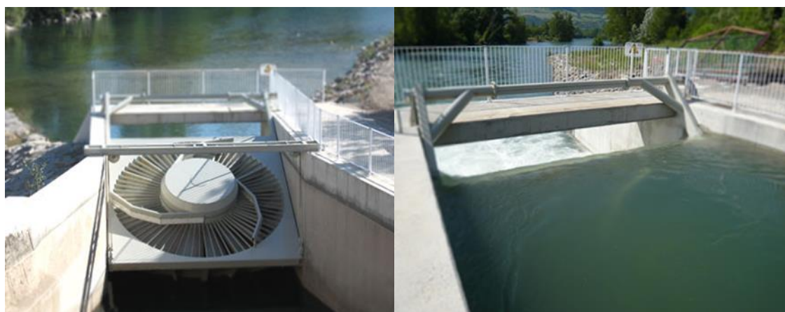
FIGURA 2. TURBINA VLH IN POSIZIONE RITIRATA (A DESTRA) E SOMMERSA (A SINISTRA) ( HTTP://WWW.VLH-TURBINE.COM/ )
